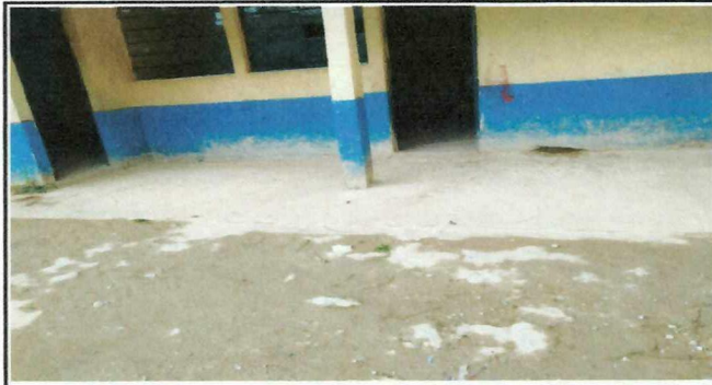
Foto 4: Rehabilitación de piso de torta de concreto en el corredor del establecimiento.
