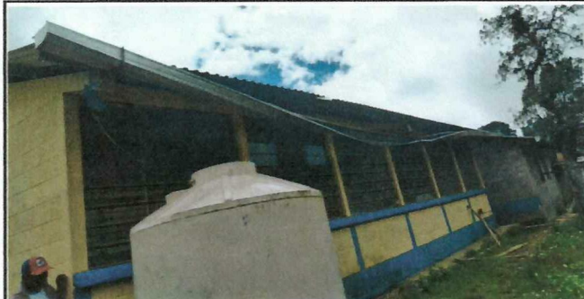
Foto 6: Sustitución de soporte o pescante de metal y canal de bajadas fluviales.
